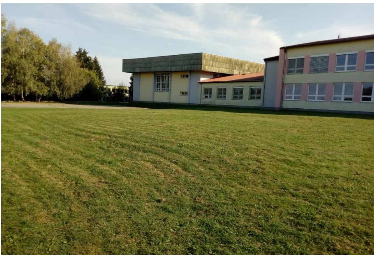
Pohled na stávající tělocvičnu
